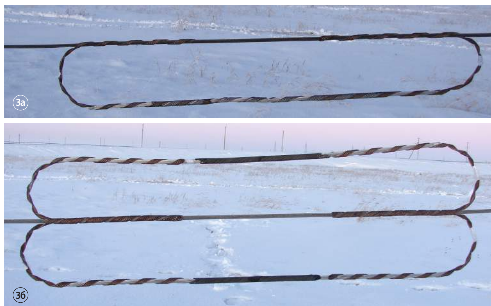
Рис. 3. Гасители пляски спирального типа а - гаситель пляски «Крыло» б - гаситель пляски «Бабочка»
