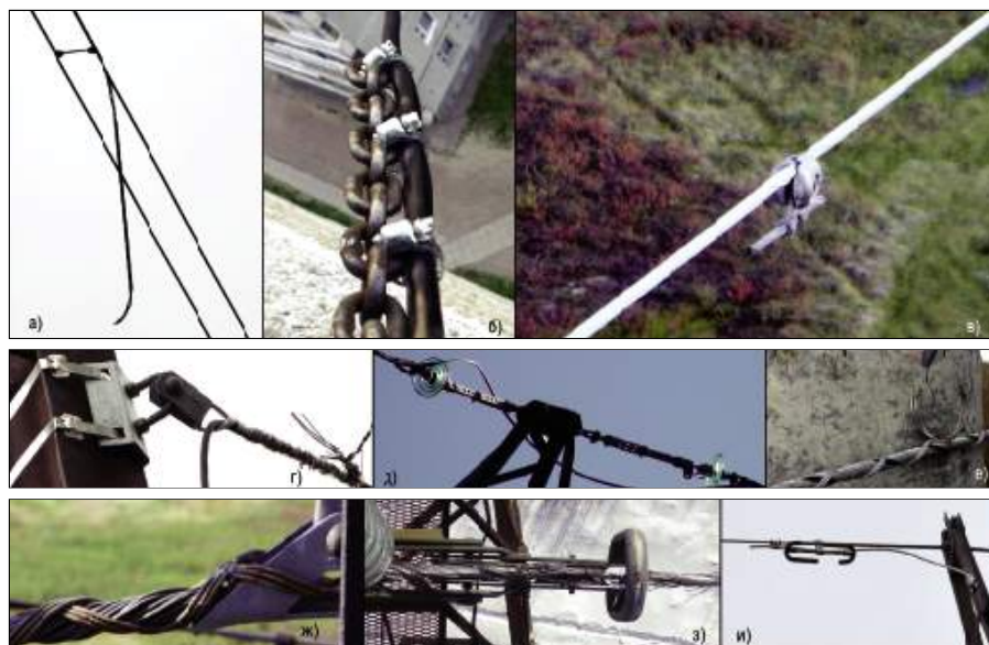
Рис. 1. Причины, вызывающие снижение ресурса работы проводов, грозотросов ВЛ и ВОЛС (а, в, е — некачественная арматура; б, г, з, и — неверное проектное решение; д, ж — ошибки при монтаже)
