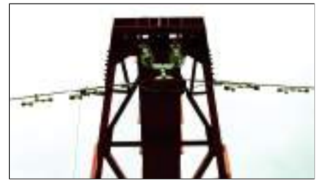
Рис. 5. Схема защиты от вибрации троса ТК-141 на переходе через р. Обь (1998 г.)
