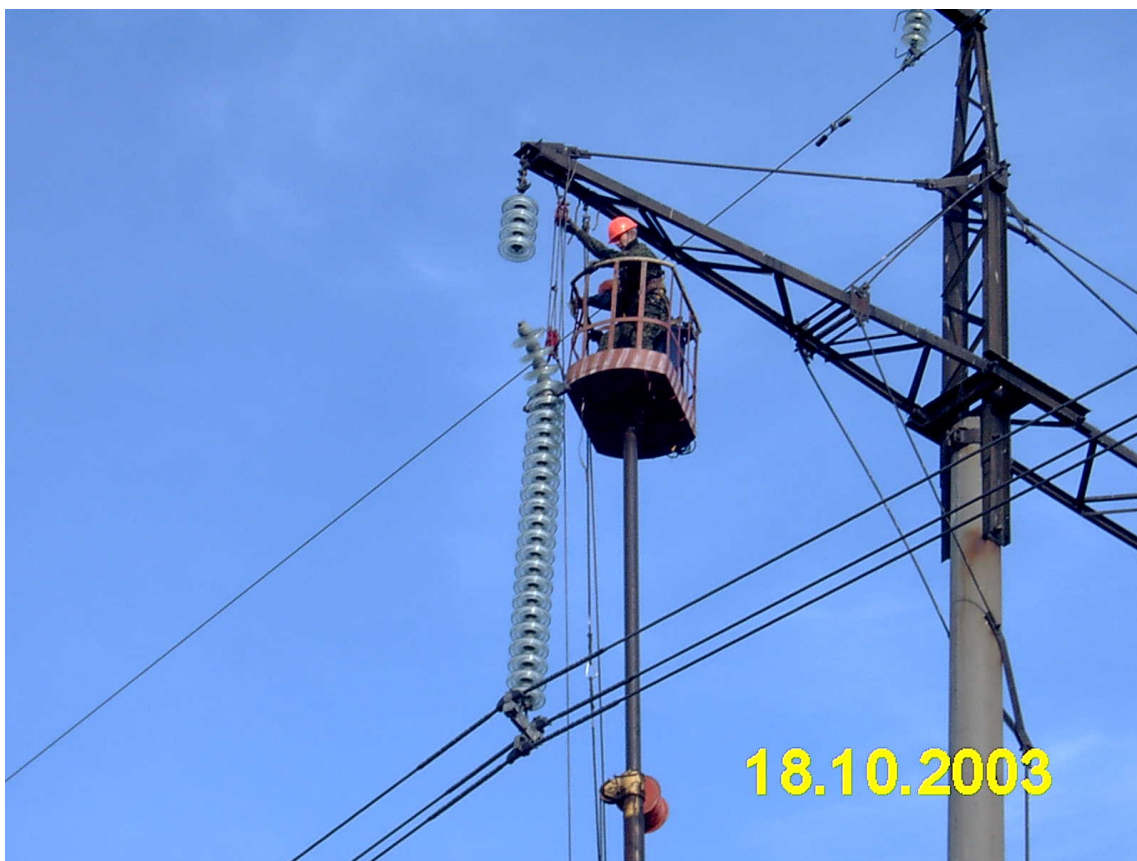
Рис. 6. Фрагмент ремонта проводов
