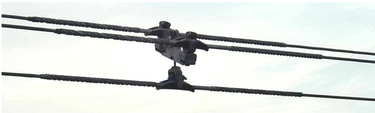
Рис. 5. Отремонтированные провода в поддерживающем зажиме
