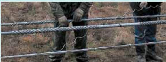
Рис. 10. Фрагмент ремонта проводов
