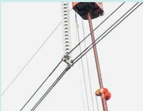
Рис. 11. Отремонтированные провода в поддерживающем зажиме
