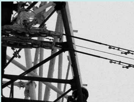
Рис. 16. Фрагмент монтажа протектора ПЗС-29,2-21 на проводе АС 300/204 в многороликовом подвесе П6Р
