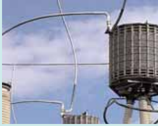
Рис. 14. Общий вид ПЗС-59,0-41 на проводе ПА-640
