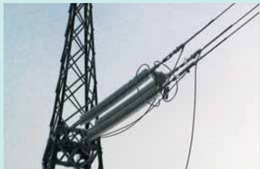
Рис. 17. Фрагмент строительства ВЛ 500 кВ
