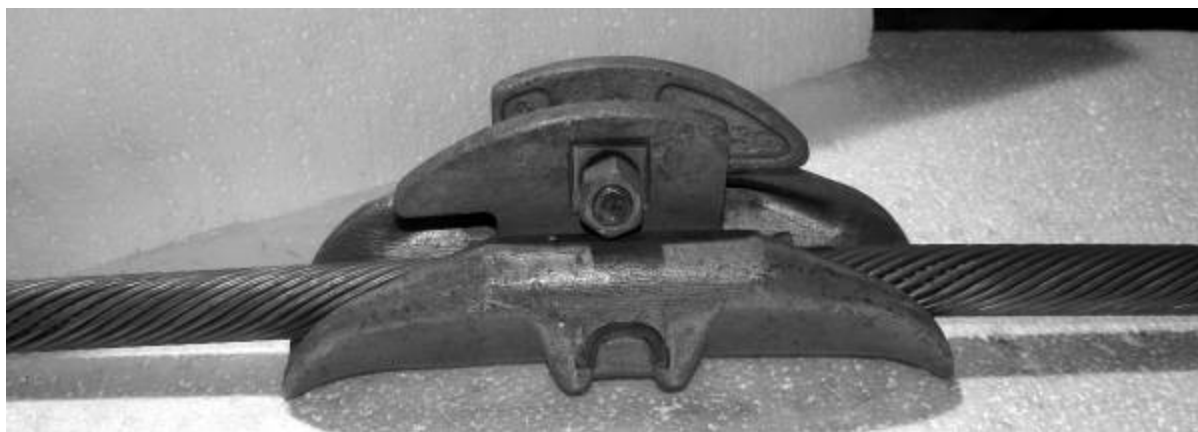
Рис. 3. Провод с защитным протектором в лодочке.
