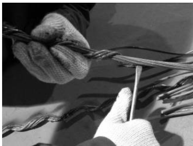
Рис.5. Применение отвертки при монтаже прядей соединителя.
