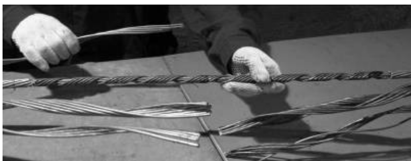
Рис. 7. Укладывание нижнего повива в провод.
