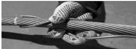
Рис 9. Монтаж второй проволоки токоведущего повива.
