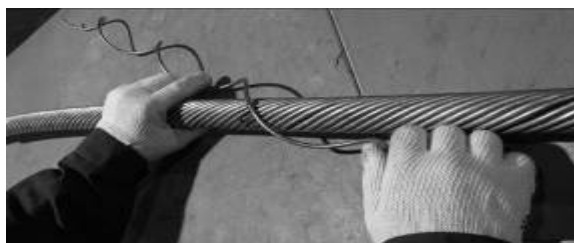
Рис. 11. Монтаж первой проволоки протектора фиксатора.
