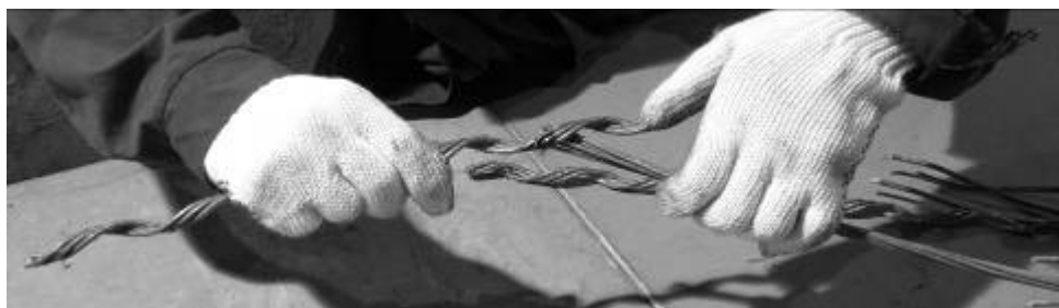
Рис. 4. Монтаж первой пряди соединителя.
