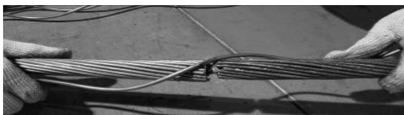
Рис. 8. Монтаж первой проволоки токоведущего повива.
