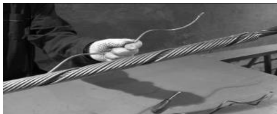
Рис. 10. Монтаж токоведущего повива.
