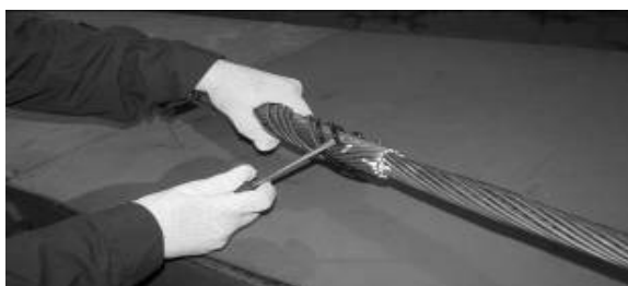
Рис. 12. Применение отвертки при монтаже протектора фиксатора.
