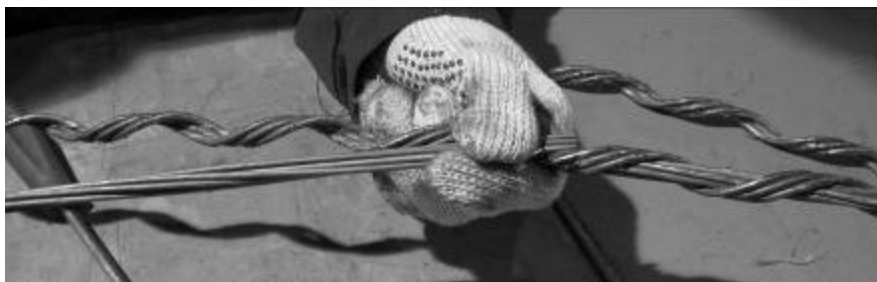
Рис. 6. Монтаж соединителя.
