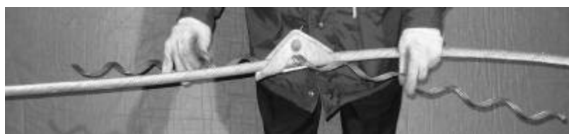
Рис. 5. Установка нижней силовой пряди.
