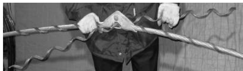
Рис. 7. Установка верхней силовой пряди.
