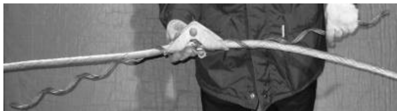
Рис. 6. Монтаж нижней силовой пряди.
