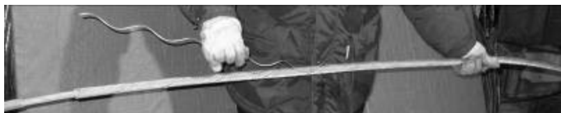
Рис. 2. Монтаж спиралей протектора.
