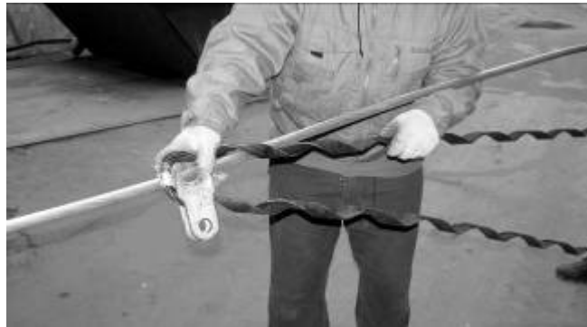
Рис.2. Установка коуша.
