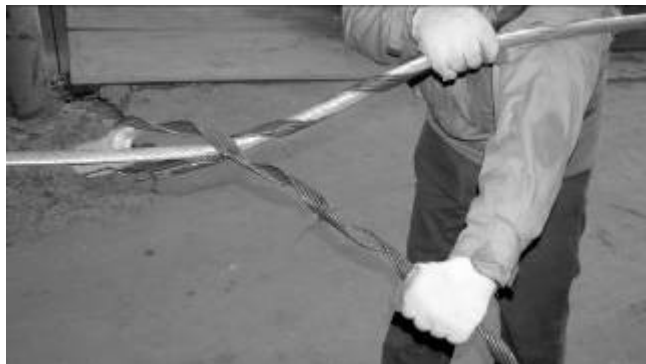
Рис.4. Монтаж первого витка второй ветви зажима
