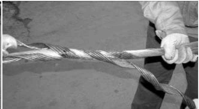
Рис. 5. Монтаж следующего витка второй ветви зажима
