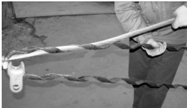
Рис.3. Монтаж первой ветви зажима.
