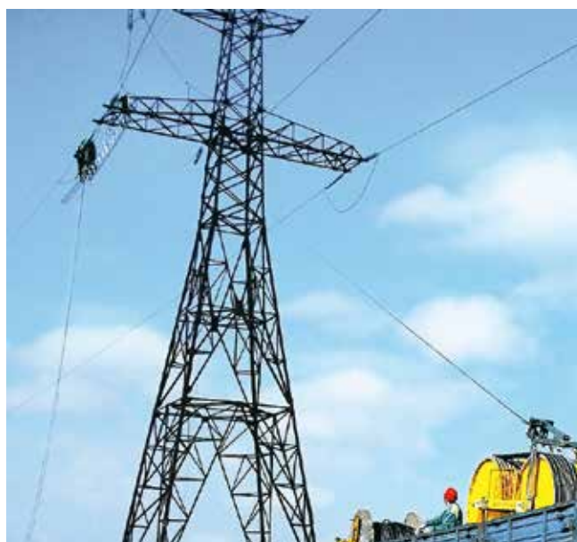
Рис. 1. Работы по замене старого провода марки АСО-300 на новый термостойкий провод с зазором GTACSR 217/49 компании «J-Power Systems» на ВЛ 220 кВ «Афипская – Крымская» (68,4 км), выполненные силами ЗАО «Электросетьстройпроект» с использованием оборудования итальянской фирмы «TESMEC» по современной технологии монтажа проводов «под тяжением»
