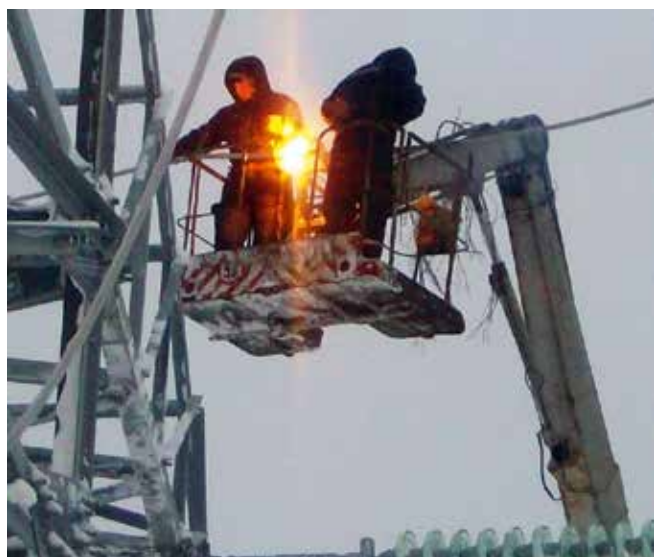
Рис. 6. Сварка шлейфов анкерно-угловых опор на переустраиваемых ВЛ 110–330 кВ при строительстве ВЛ 330 кВ Гатчинская – Лужская (2011)
