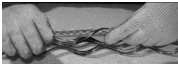
Рис. 5. Монтаж первой спирали токоведущего повива.
