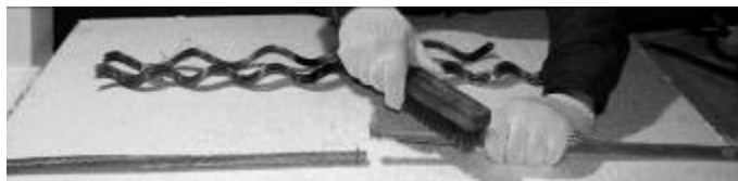
Рис. 3. Зачистка повива провода.
