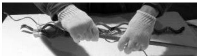
Рис. 5. Монтаж первой спирали токоведущего повива
