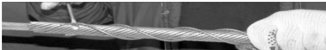
Рис. 10. Применение отвертки при монтаже спиралей протектора фиксатора.
