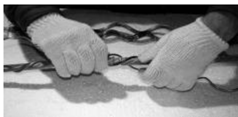
Рис. 6. Монтаж второй спирали токоведущего повива.
