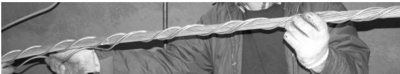
Рис. 20. Монтаж токоведущего повива.
