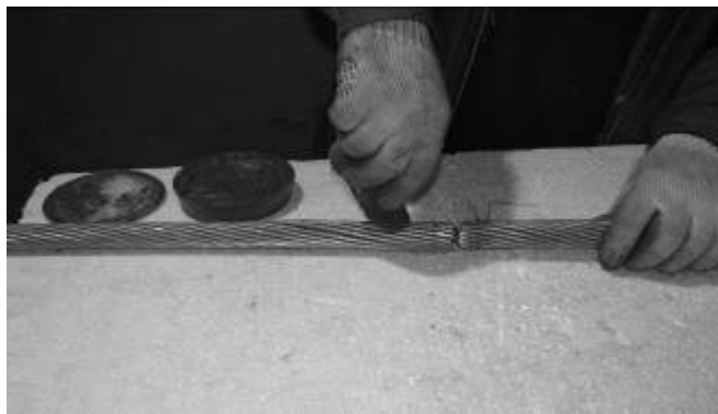
Рис. 17. Нанесение смазки.
