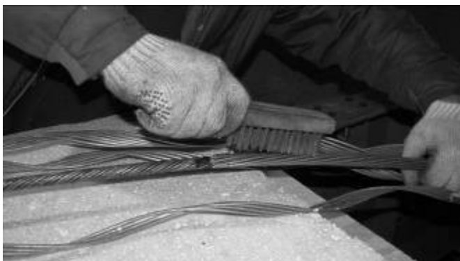
Рис. 12. Зачистка щеткой повива.
