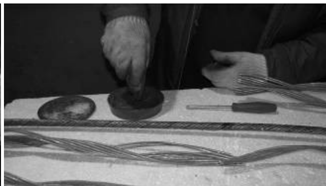
Рис. 13. Нанесение смазки.
