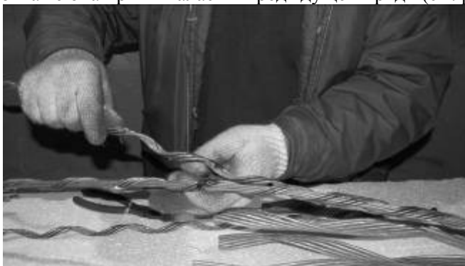
Рис. 9. Монтаж второй пряди соединителя.
