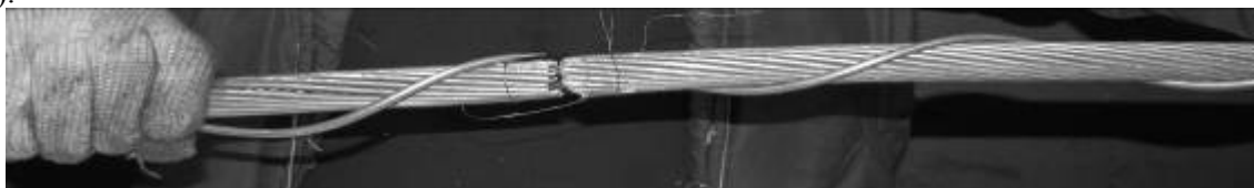
Рис. 18. Монтаж первой спирали токоведущего повива.
