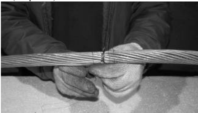
Рис. 15. Установка бандажей на верхний повив провода.
