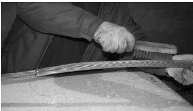
Рис. 16. Зачистка повива щеткой
