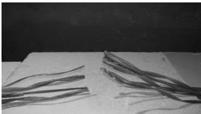
Рис 3. Расплетены два повива провода.
