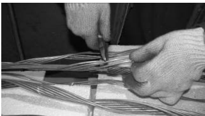
Рис. 10. Откусывание проволок нижнего повива.
