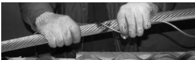
Рис.21. Монтаж первой спирали протектора фиксатора.
