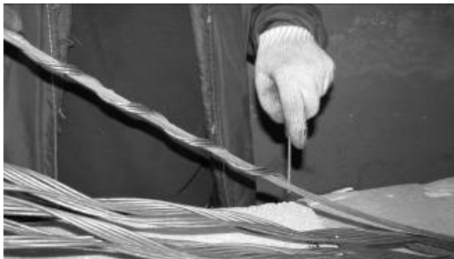
Рис. 5. Применение отвертки для монтажа соединителя.
