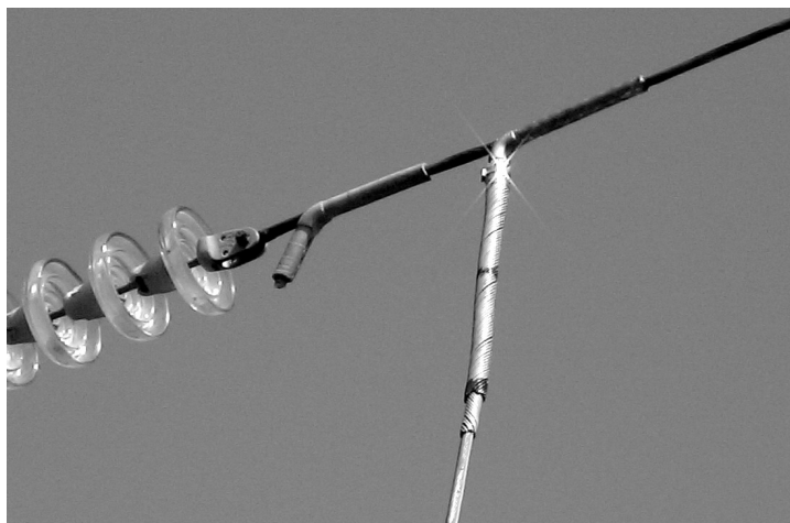
Рис. 4. Зажим ШС-24,0-53 на линии
